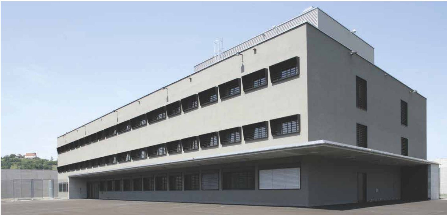
Ansicht Süd- und Ostfassade
