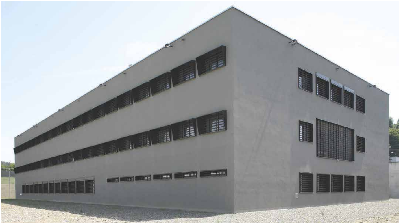
Ansicht Nord- und Westfassade
