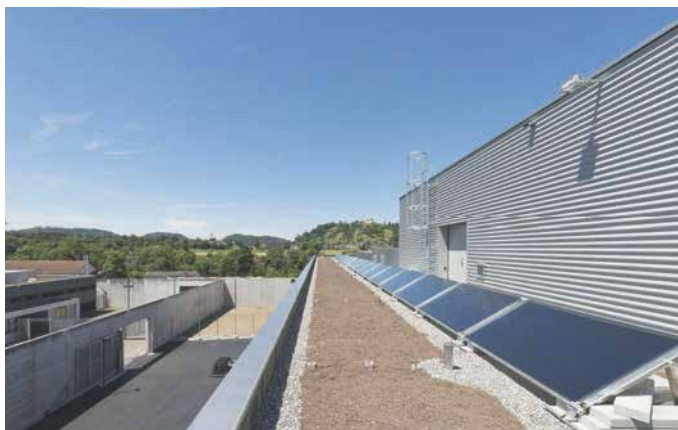
Dachansicht mit Technikgeschoss
