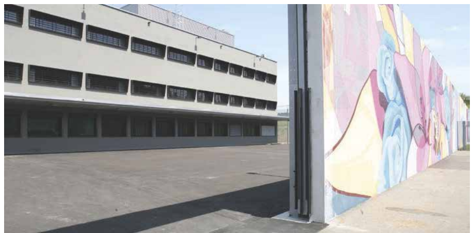
Blick vom Mauerdurchbruch auf das neue Gebäude
